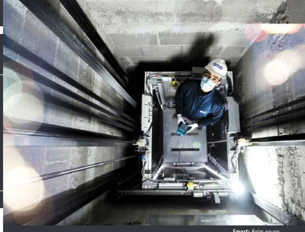
**Smart:** Beim neuen Gen360™ Aufzug können Wartungsarbeiten direkt aus dem Fahrkorb heraus erfolgen
