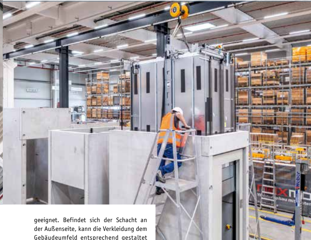
Einbau des Fahrkorbs in das Schachtelement
