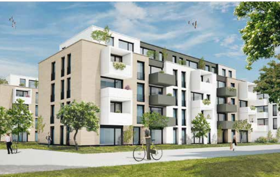
In der Templiner Seestraße entstehen moderne Gebäude mit Balkonen und viel Grün
