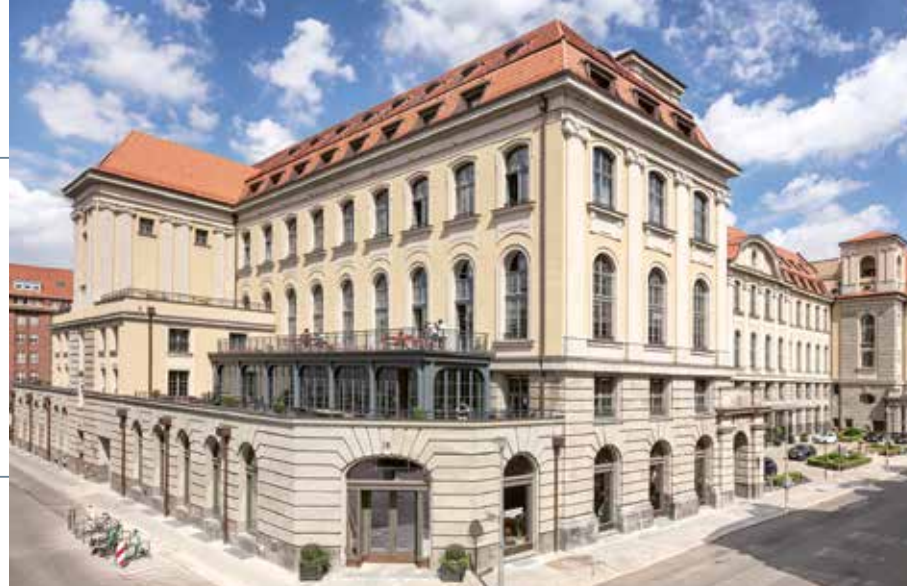
Haupttelegraphenamt Berlin: denkmalgerechte Sanierung und Umnutzung in Hotel, Büros und Gastronomie
