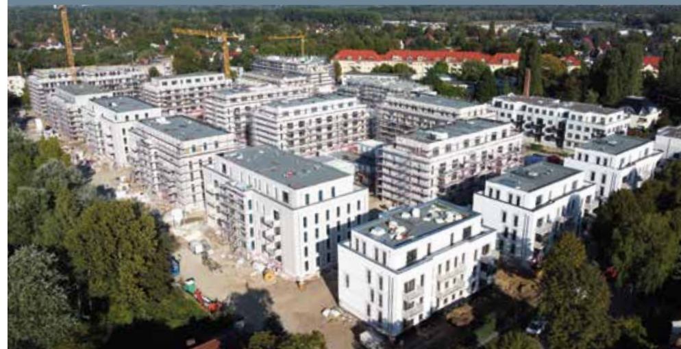
Das Wohnquartier an der Idunastraße soll noch 2024 fertig werden
