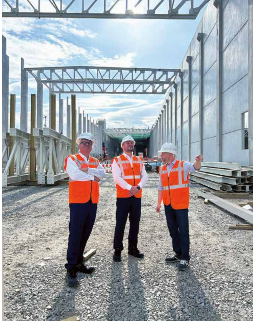
Daniel Keller (m.) auf der Baustelle des Bahnwerkes Cottbus
