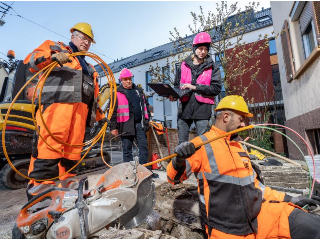
Baubegleiter der Telekom überprüft die Fortschritte an Glasfaser-Baustelle | Deutsche Telekom
